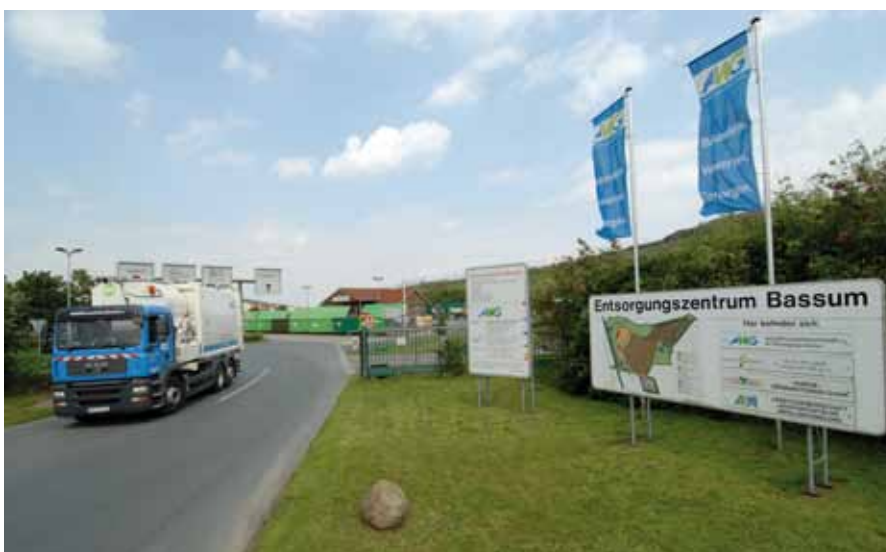
Das Entsorgungszentrum Bassum hat ein jährliches Abfallvolumen von rund 120 000 t. Hier werden die Abfälle sortiert, gelagert aufbereitet und verwertet
