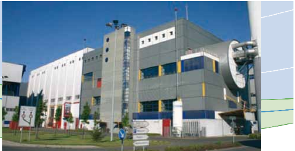
In dem Abfallheizkraftwerk Neunkirchen dürfen 150.000 t Abfall pro Jahr behandelt werden
